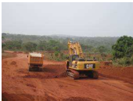
La route en construction
